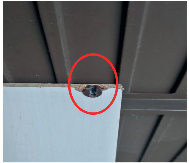
BEVESTIGINGSPUNT BESCHADIGD
